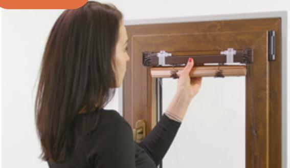
**Přiložte** žaluzii na doraz k horní zasklívací liště a **vystředěte**.
