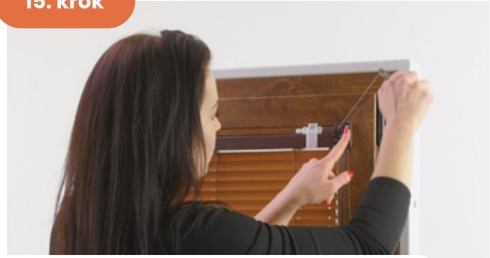
Pomocí kleští **vypněte silon** tahem od okna.
