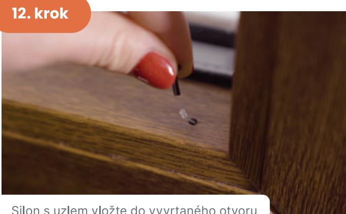
Silon s uzlem vložte do vyvrтанého otvoru a vložte **fixační kolíček**.
