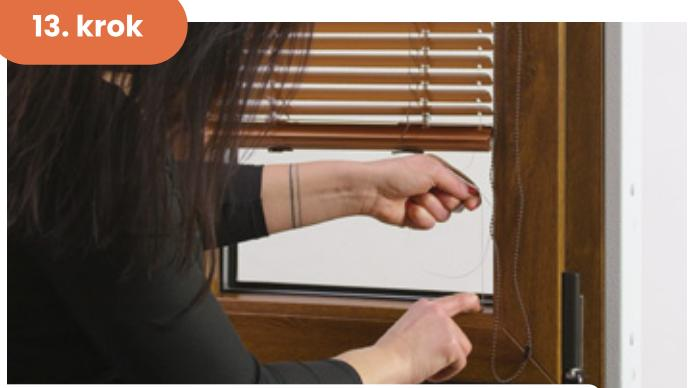
Jednou rukou **fixační kolíček přidržte** a druhou **zatáhněte za silon**, aby se v liště upevnil.
